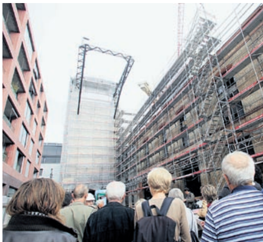
Die Komplexität der Baustelle beeindruckt die Teilnehmer am Rundgang. Bild: dc
